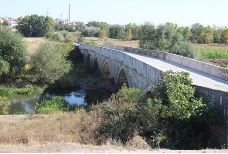
Fotoğraf 29: Köprü Genel Görünüm.
