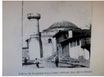
FAZLULLAH PAŞA CAMİİ
